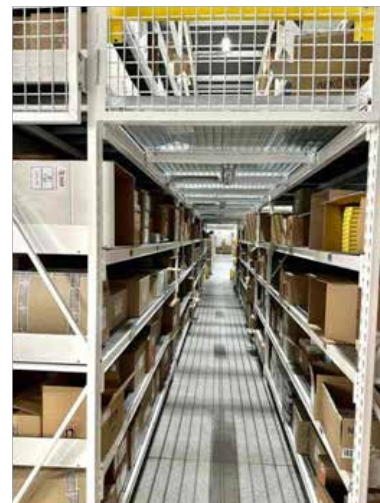
Рисунок 10. – Внешний вид мезонина в аптечном складе Гродненского РУП «Фармация»
