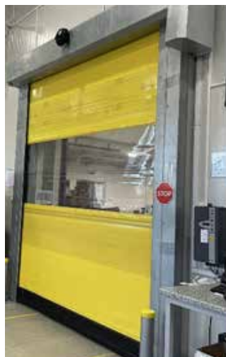
Рисунок 3. – Автоматические скоростные пленочные ворота в помещении аптечного склада Гродненского РУП «Фармация»
