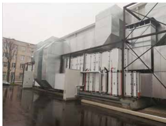
Рисунок 2. – Установка климат-контроля аптечного склада Гродненского РУП «Фармация»
