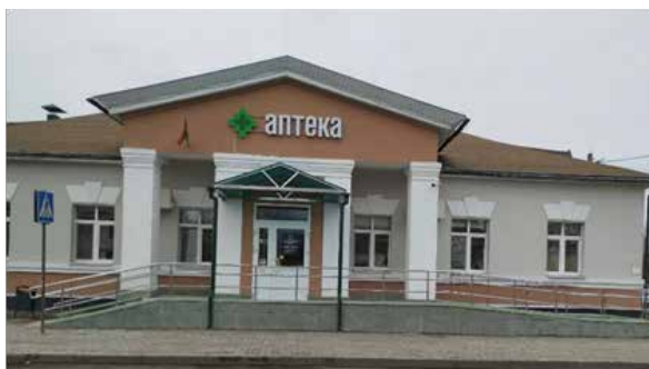
здание после ремонта
